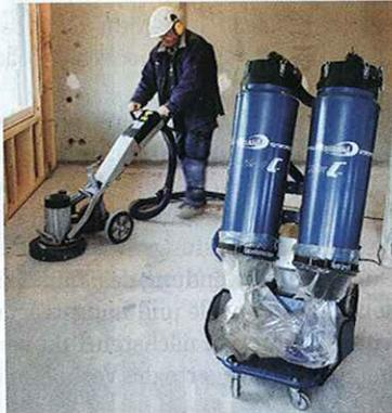
Staub besteht aus einer Ansammlung von verschiedenen großen Teilchen aus einem oder mehreren Stoffen. Die Partikelgröße von feinem lungengängigem Staub liegt zwischen 0,001-0,1 mm. Dustcontrol bietet mit zentralen Absauganlagen, Industriestaubsaugern wie auch Bausaugern effektive Absaugtechnik
