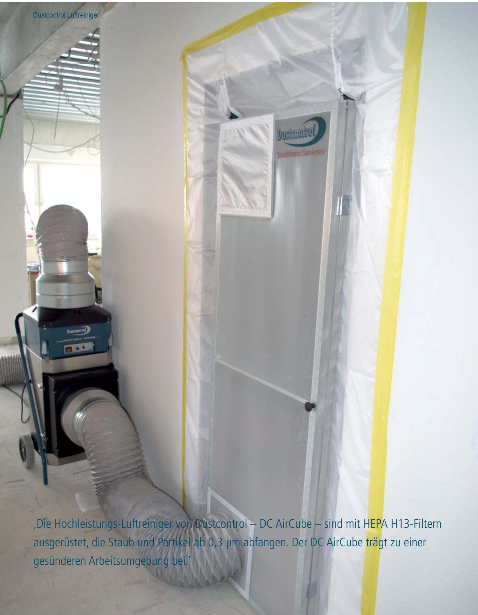
„Die Hochleistungs-Luftreiniger von Dustcontrol – DC AirCube – sind mit HEPA H13-Filtern ausgerüstet, die Staub und Partikel ab  $0,3 \mu\text{m}$  abfangen. Der DC AirCube trägt zu einer gesünderen Arbeitsumgebung bei.“
