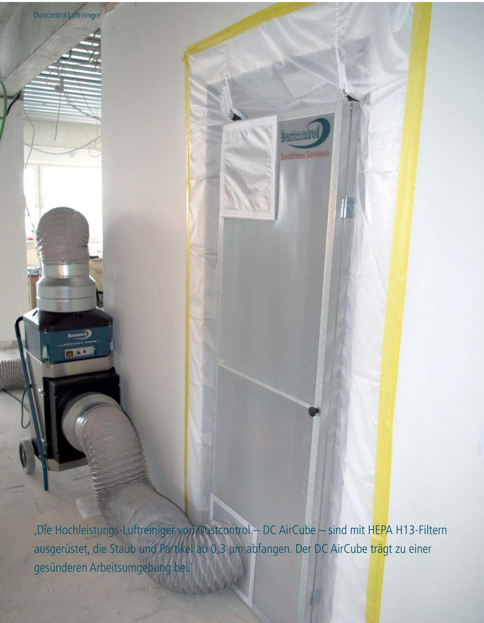
„Die Hochleistungs-Luftreiniger von Dustcontrol – DC AirCube – sind mit HEPA H13-Filtern ausgerüstet, die Staub und Partikel ab 0,3 µm abfangen. Der DC AirCube trägt zu einer gesünderen Arbeitsumgebung bei.“
